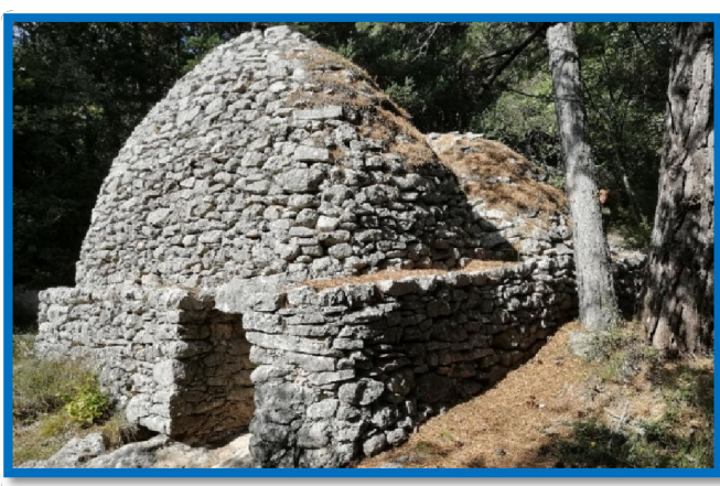
34) Une borie du pays pour un logement de fortune.
