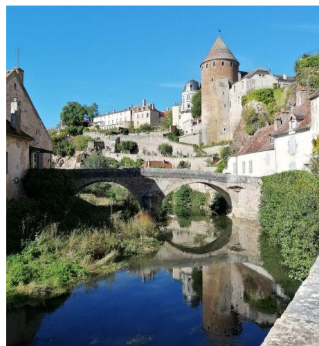
5 Ancien pont d'accès de la ville Le pont des Minimes
